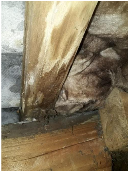
Vand trænger ind utætte rygninger samt manglende fugleklodser
