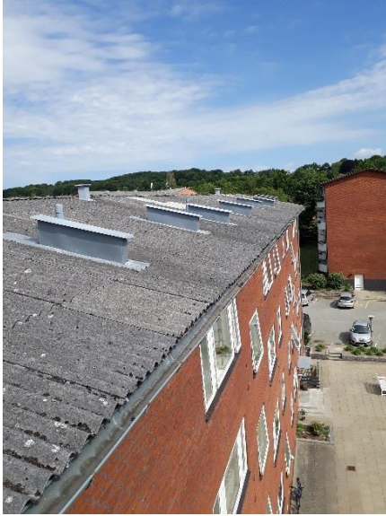
Tagflade på bygning 71
