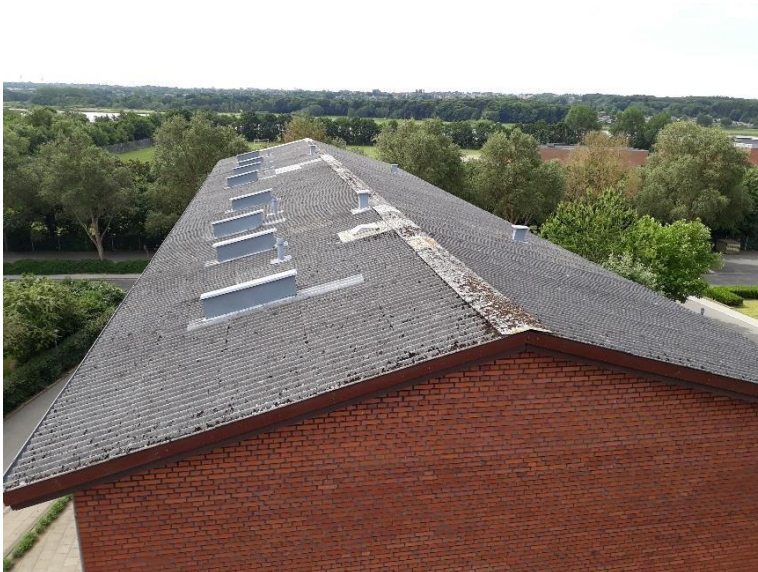
Tagflade på bygning 71
