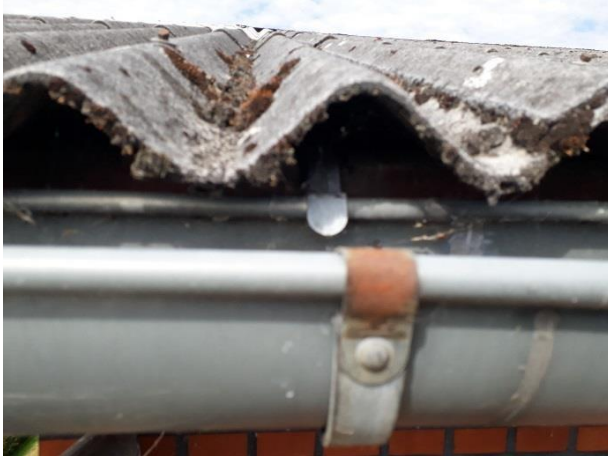
Lås mellem tagrende og rendejern med rust
