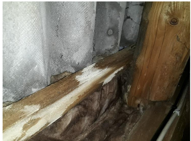
Vand trænger ind utætte rygninger samt manglende fugleklodser
